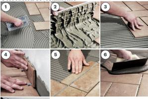
1 La posterior colocación del revestimiento debe ser realizada con gel-adhesivo mineral de la línea H40; en caso de lluvia sobre el producto no endurecido totalmente, comprobar atentamente la idoneidad de la posterior colocación.
