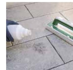
Una vez endurecida la junta (tras al menos 7 días), restos de suciedad y manchas se podrán eliminar con **Fuga-Shock Eco**. Distribuir el producto sobre la superficie a tratar usando el fieltro abrasivo. Dejar actuar Fuga-Shock Eco durante 3/5 minutos, después realizar las mismas operaciones de enjuagado y secado indicadas para la limpieza del día después.
