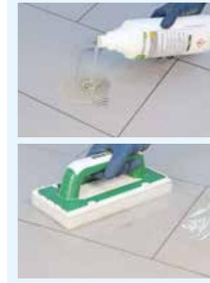
Una vez endurecida la junta, los restos de suciedad y manchas se podrán eliminar con **Fuga-Soap Eco** diluido según la cantidad de residuo a eliminar y según los tiempos de curado de Fugalite®.
